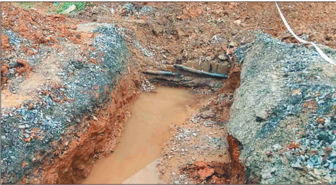
पाइप लगाने के लिए सड़क में खोदे गए गड्ढे।
